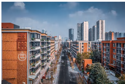
成都市玉林东路风貌更新项目
